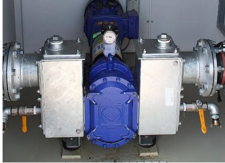
Die Drehkolbenpumpe mit Anschlussboxen
